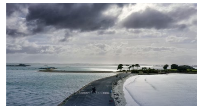
Lieu d'assemblage des fourreaux pour les câbles sous-marins sur l'îlot Sainte-Anne à Saint-Pol-de-Léon.
